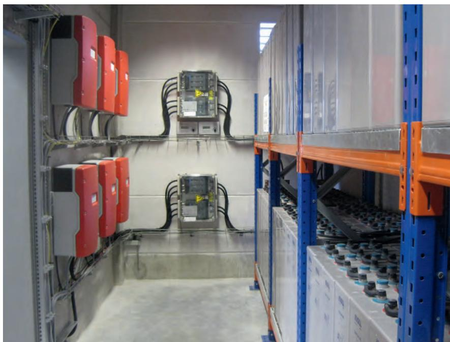
Der Batterieraum der EnFa mit insgesamt 400 kWh Kapazität.
